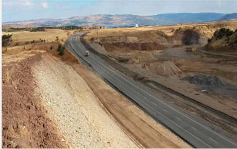
Karayolları 12. Blg Md. Göle-Selim İl Devlet Yolu Yapım İşi
