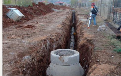
İller Bankası Iğdır-Halfeli Kanalizasyon Yapım İşi
