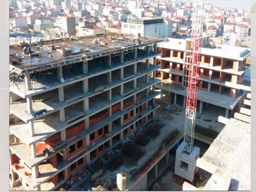
SKY NOVİTA KURTKÖY 120 Daire inşaatı
