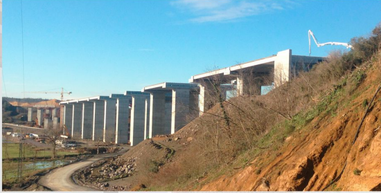
ICA - Kuzey Marmara Otoyolu V23 Viyadük İnşaatı Yapımı
