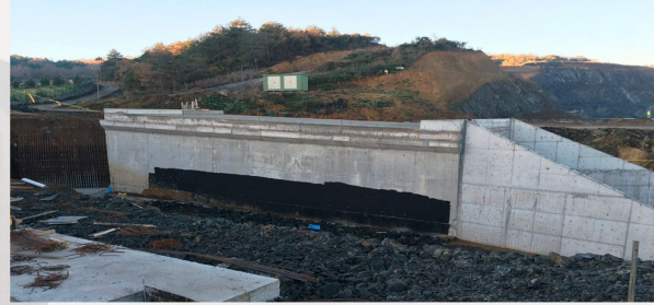
ICA - Kuzey Marmara Otoyolu Çeşitli Altgeçit ve Üstgeçit Yapım İşleri
