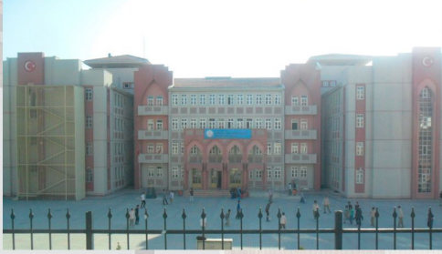
TOKİ Esenyurt 32 Derslikli Okul İnşaatı
