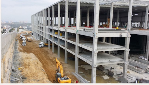
Gebze OSB Fabrika Binası Kaba İşleri
