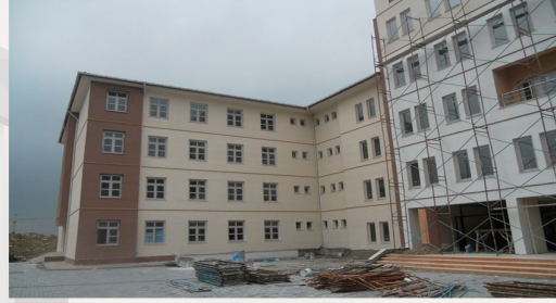
TOKİ Ispartakule 40 Derslikli Okul İnşaatı
