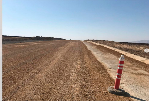
Karayolları 18. Bölge Md. Kars-Susuz Şehir Geçişi Yol Yapım İşİ
