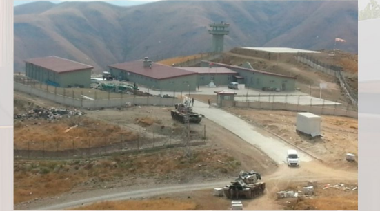
TOKİ Doğubeyazıt Sınır Karakolu ve Yolları Yapım İşi
