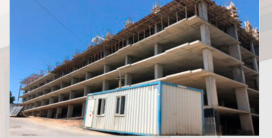
Hamzaoğulları Pendik Tual Teras Kaba İnşaatı
