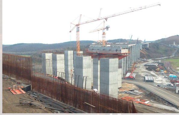
Kuzey Marmara Otoyolu Riva Viyadüğü Yapım İşİ
